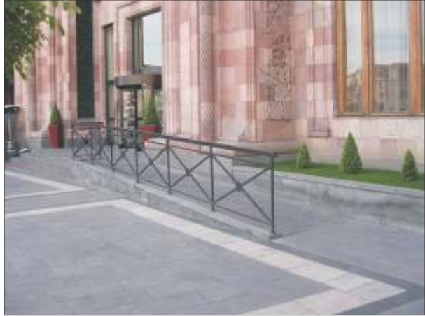
Լուսանկար 3. Շինարարական նորմերին համապատասխանող թեքահարթակ
