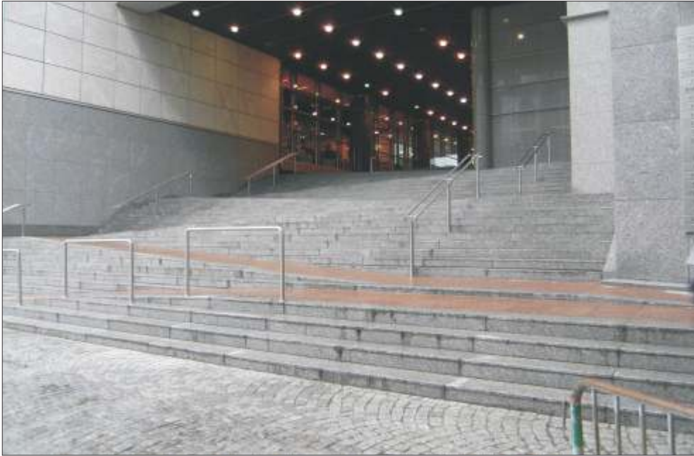
Լուսանկար 8. Այսպիսի զիգզագաձև թեքահարթակներ կարելի է կիրառել բազմաթիվ աստիճանների առկայության դեպքում, օրինակ՝ գետնանցումներում
