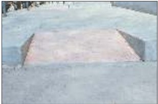
Լուսանկար 14. Մայթեզրի ճիշտ ցածրացում (ներքևում հավասարվում է փողոցի մակարդակին)
