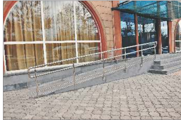
Լուսանկար 12. Բազրիքը թեքահարթակից երկար պետք է լինի
