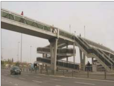
Լուսանկար 17. Աջից՝ աստիճաններ, մեջտեղում՝ զիգագազան թեքահարթակ
