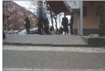
Լուսանկար 15. Մայթեզրի սխալ ցածրացում (ավարտվում է բորոյուրով)
