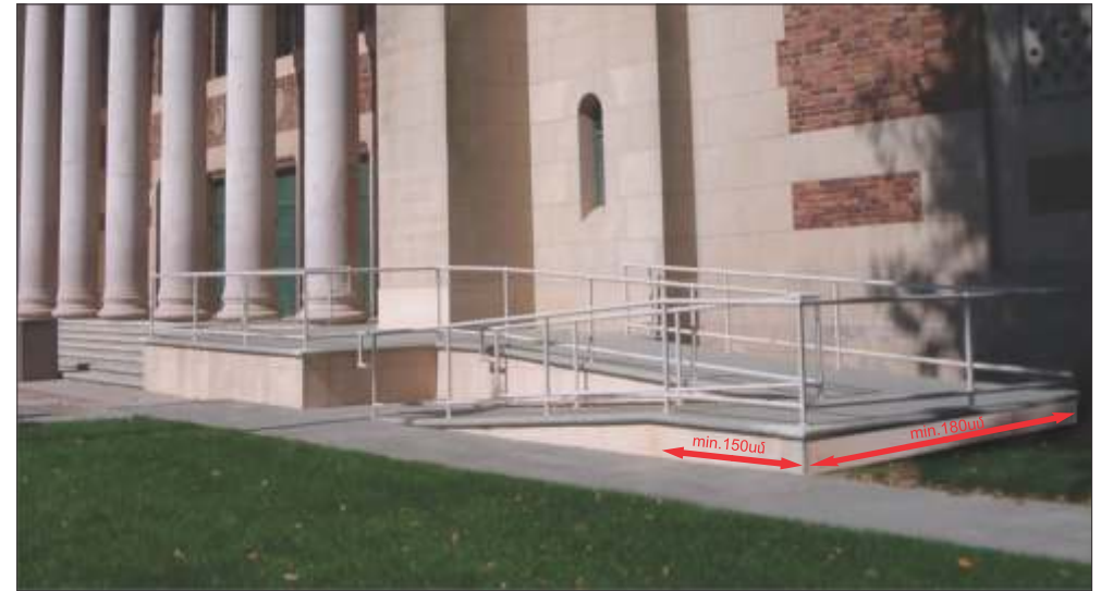
Լուսանկար 5. Չափանիշներին համապատասխանող թեքահարթակ: Կարմիր գույնով նշված են միջանցիկ հատվածի նվազագույն չափերը
