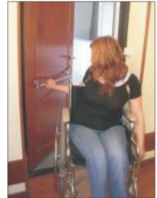
Լուսանկար 19. Բռնիչը թույլ է տալիս ինքնուրույն փակել դուռը
